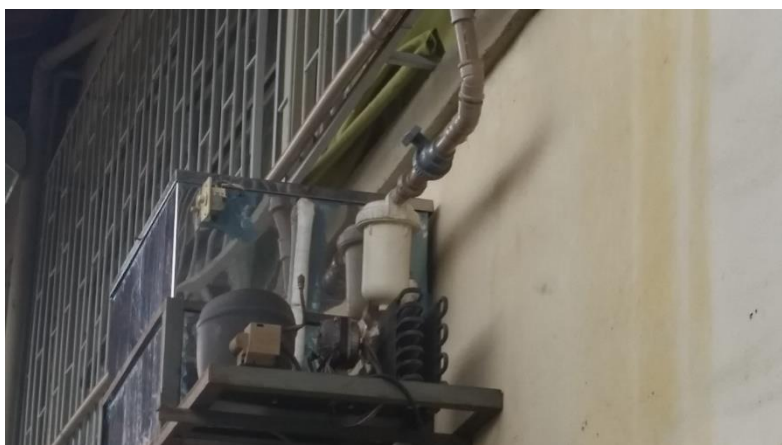
Figura 9: Filtro principal da edificação
